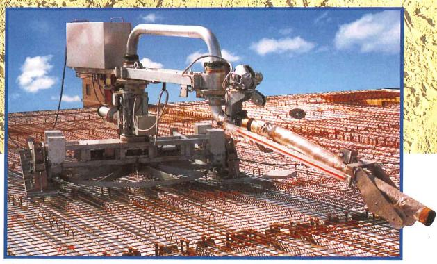
コンクリート打設ロボット「デービーロボ」は、コンクリート床仕上げの第一段階であるコンクリート打設作業をロボット化したものです。コンクリート打設は、ポンプ車より打設フロアまで圧送された生コンクリートを、作業員がホース筒先を打設位置に移動させながら行っていました。足場が不安定で重量物を持っての移動が大変な重労働であり、安全性にも問題が――。「デービーロボ」は自動化によりこれらの苦渋作業の解消と作業の安全を実現いたしました。
