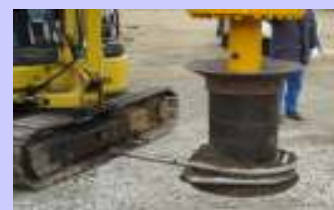
12 既設管巻取り状況
