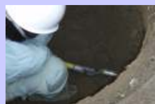
9 既設管末端に新設管セット
