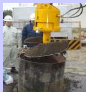
9 既設管末端に新設管セット
