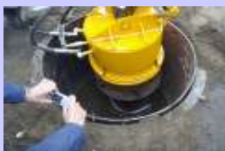
11 既設管巻取り、新設管引込み
