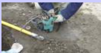
11 既設管巻取り、新設管引込み
