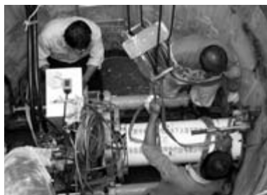
写真-4 先導管推進
