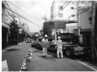
写真-1 トレーラ搬入
