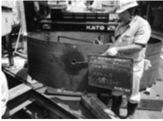
写真-4 先端ケーシング滑材注入工
