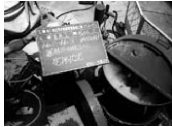
写真-6 掘削添加材
