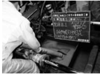
写真-7 排土状況
