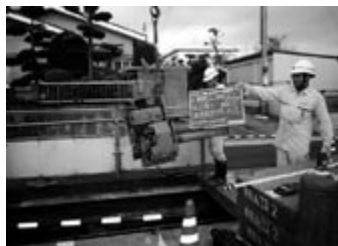
写真-1 本体吊降し
