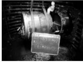
写真-9 先導管回収
