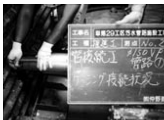
写真-6 ケーシング継足し
