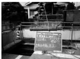
写真-3 先導体吊降し
