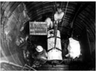
写真-2 φ500mm先導管吊降し
