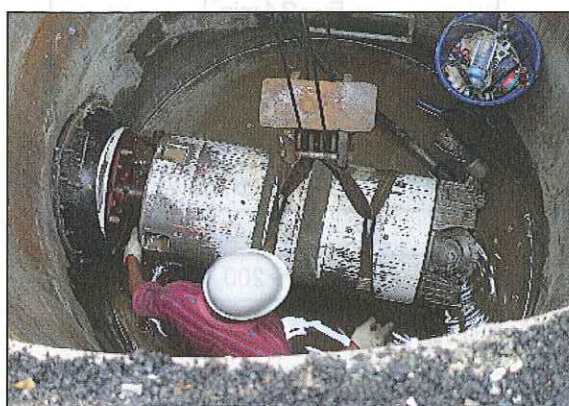
先導管回収 (到達坑 1890mm φ)
