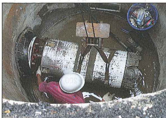
先導管回収 (到達坑 1890mm φ)
