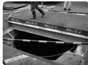
覆工板開口時状況 3×1mの覆工板を1枚外した状況。
