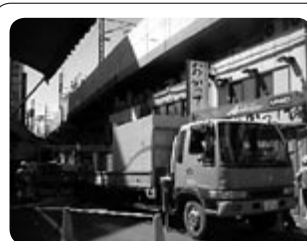
設備は車上搭載 アート機駆動用の油圧ユニットは夜間開放のためトラック上に設置。
