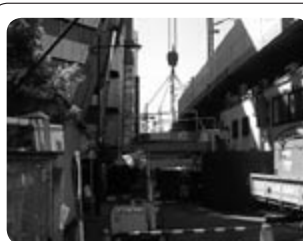
アート機設置状況 覆工板を開けた施工場所へアート機をクレーンで吊り込み、設置。
