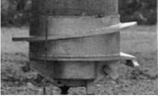
写真-1 施工機械と推進ビット
