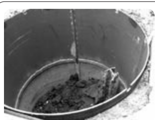
鋼製ケーシング 残置されたH型土留め材の状況。
