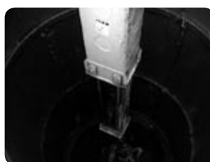
掘削 ケーシング内部のテレスコによる掘削状況。
