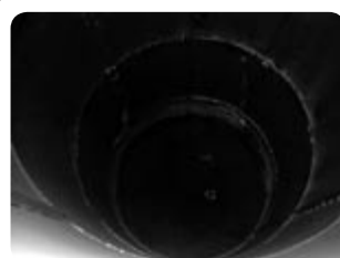
掘削状況 掘削後のケーシング内部状況。
