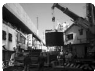
ケーシング吊り込み ケーシングをクレーンで吊り込み。
