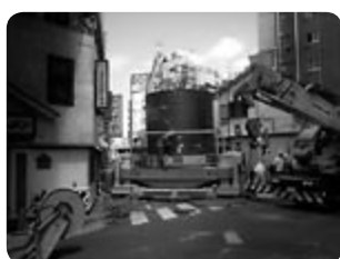
ケーシング継足し ケーシングを溶接。
