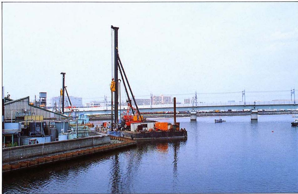
● 2 軸機による地盤改良施工(水上工事) Soil consolidation work ( 2-SHAFTS )
