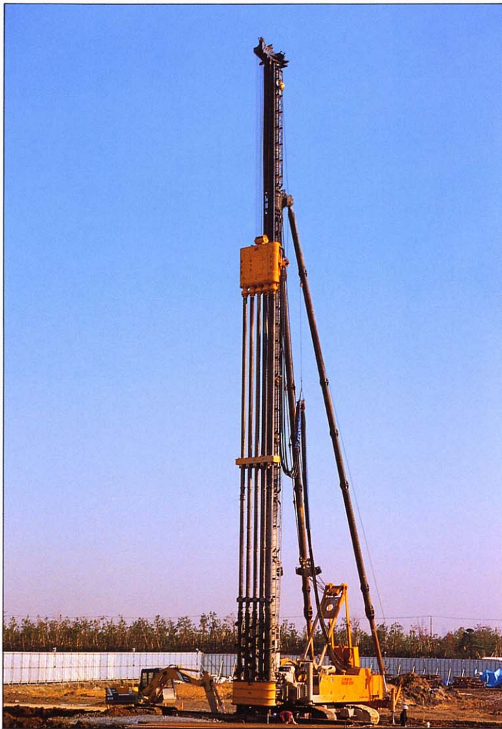
● 5軸機による連続壁施工 Soil-retaining wall work (5-SHAFTS)
