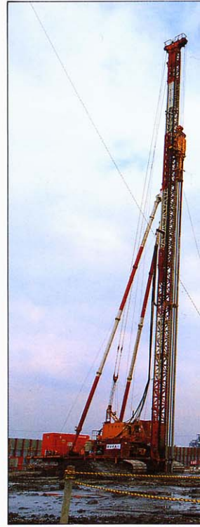
● 2 軸機による地盤改良施工 Soil consolidation work ( 2-SHAFTS )
